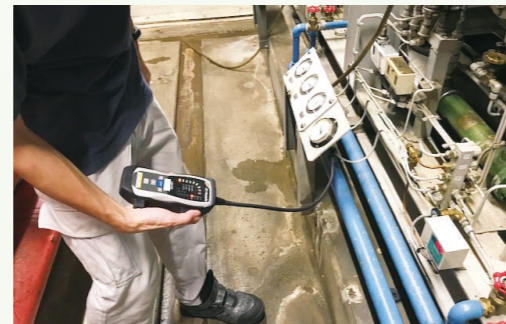
冷媒漏えい点検
